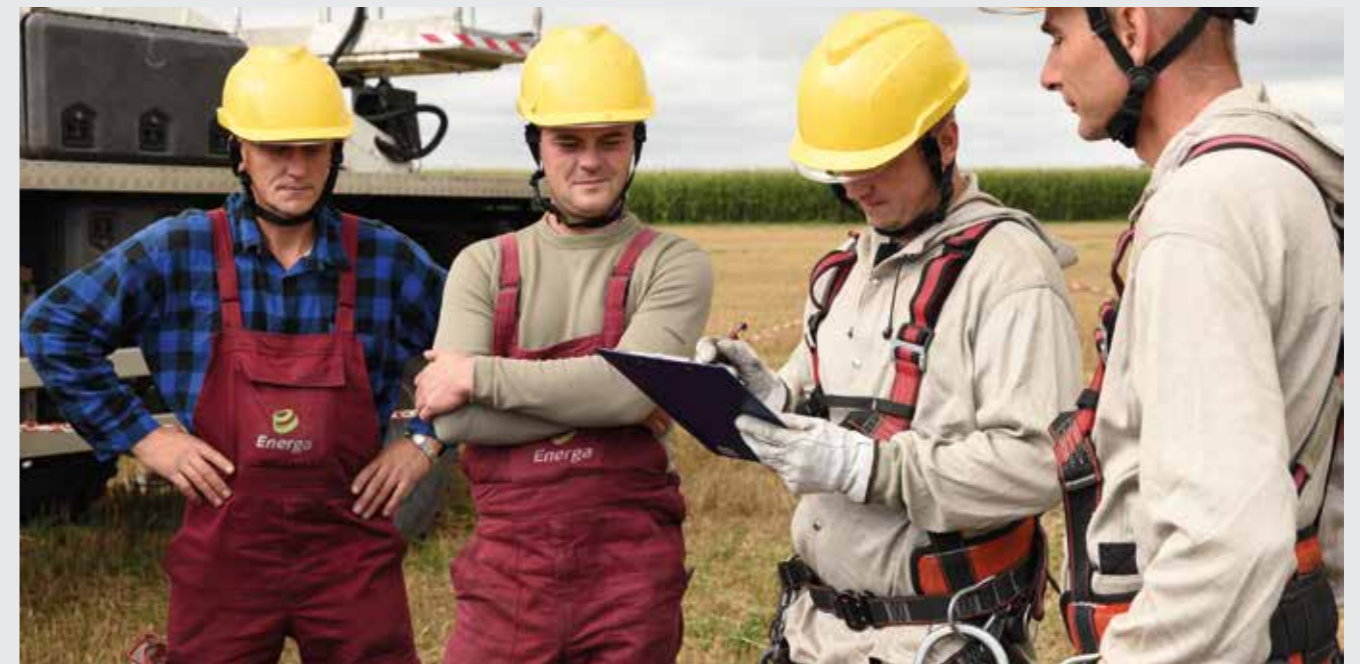
» ENERGA-OPERATOR, DOPUSZCZENIE BRYGADY DO PRACY POD NAPIĘCIEM
